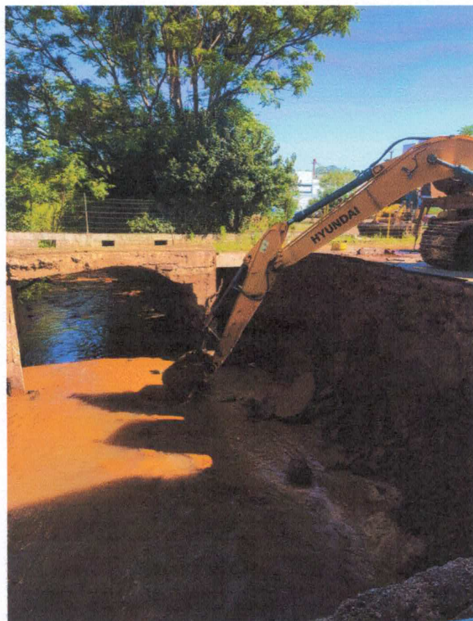
Limpeza dos escombros que caíram sobre o Arroio Sananduva na Rua Ernesto Damas.
