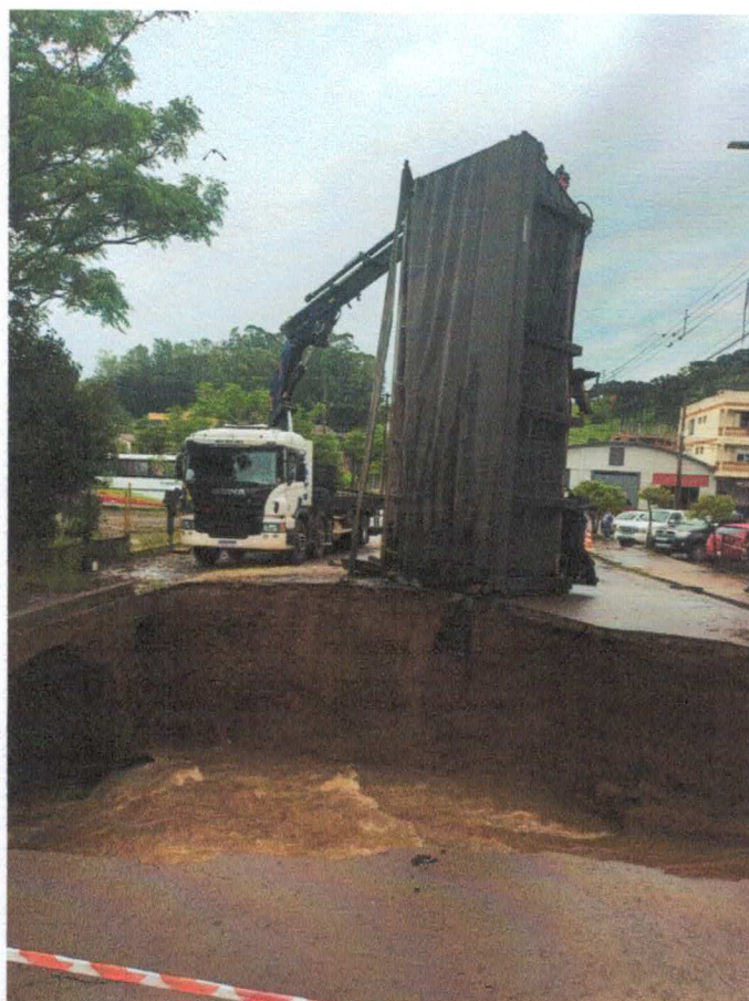
Retirada da parte do caminhão bi trem que caiu no Arroio Sananduva.
