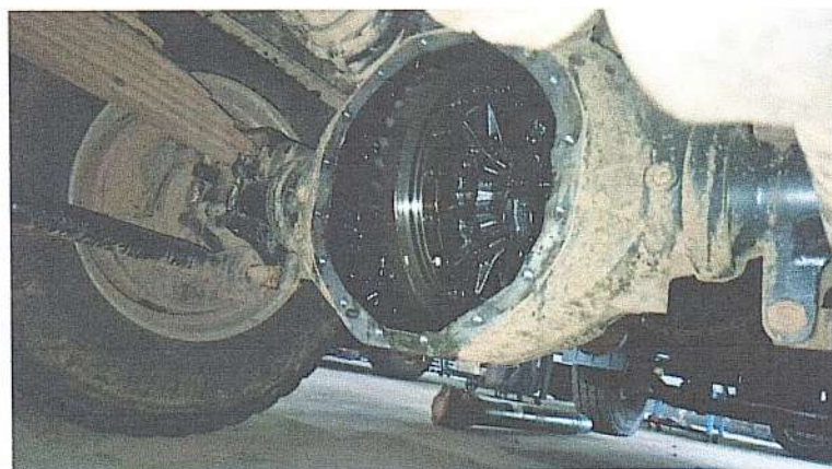
Vista geral do conjunto diferencial dianteiro do tandem parcialmente desmontado
